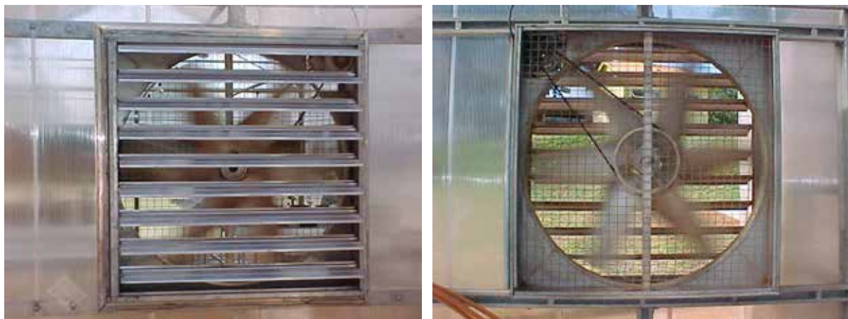
Figura 11 - Ventilador axial utilizado em abrigos para cultivo protegido e mecanismo de proteção do exaustor, com aletas móveis (abertura e fechamento automáticos) para evitar a entrada de insetos.
